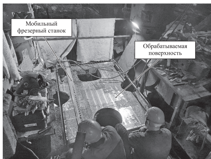
Рис. 8. Процесс механической обработки основания пресса мобильным фрезерным станком
