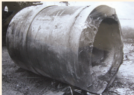
Рис. 3. Разрушение цилиндра пресса силой 20 МН по галтели фланца. Плоскость распространения трещины перпендикулярна оси цилиндра
